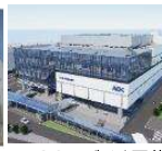
AGCのバイオ医薬品 CDMO拠点(建設中)
