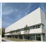
AGCのバイオ医薬品 CDMO拠点(建設中)
